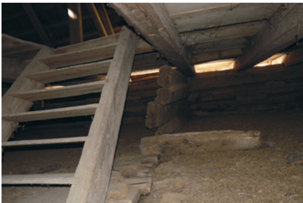
33. Severovýchodní trakt, prostor pod roubenou komorou v krovu s fragmenty starší roubené komory, pohled kzápadu, 2015, foto Z. Křenková. North-east section, the area under the timbered chamber in the roof truss with fragments of an earlier timbered chamber, view towards west. Nordöstlicher Trakt, Raum unter der gezimmerten Kammer im Dachstuhl mit Fragmenten einer älteren gezimmerten Kammer, Blick in Richtung Westen.
