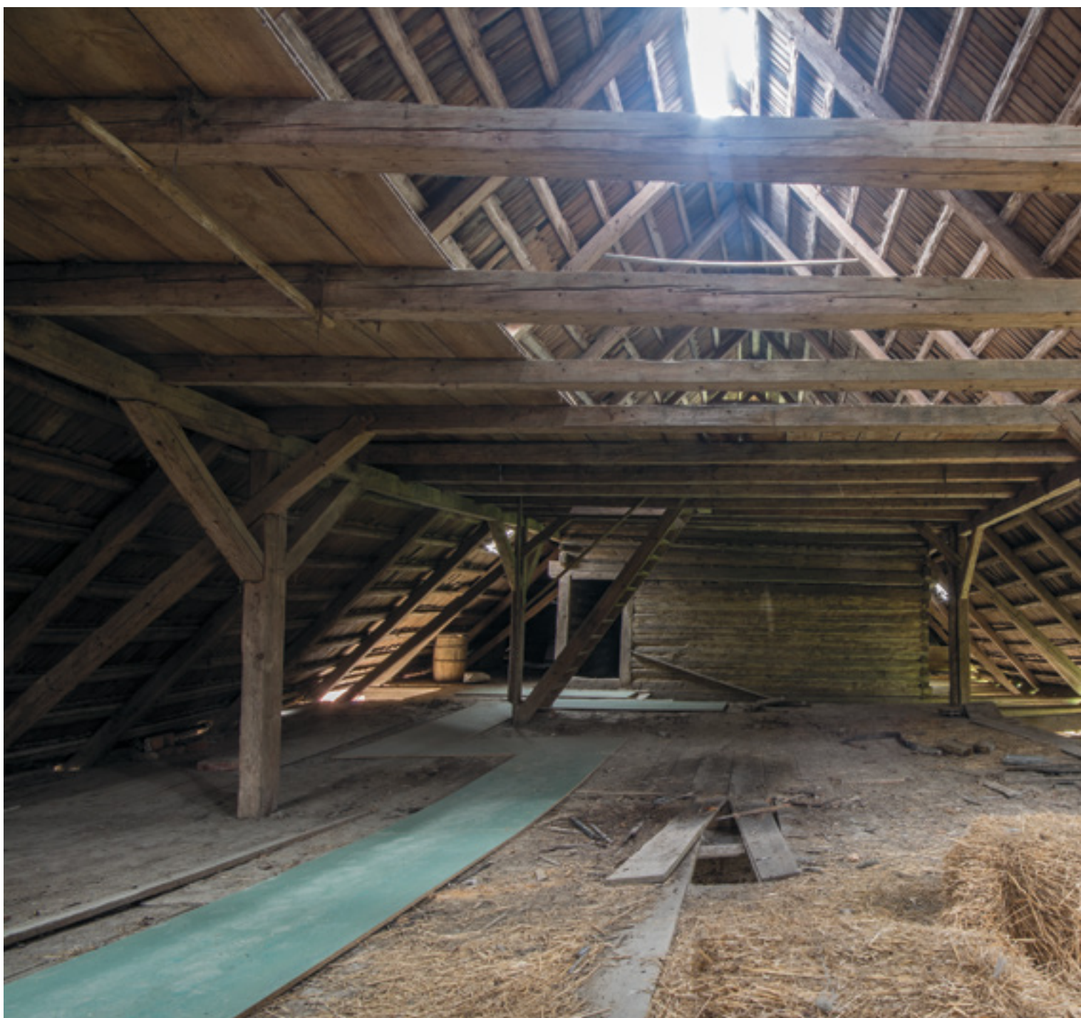
34. Konstrukce prvního podlaží krovu nad roubeným domem v severovýchodním traktu, pohled k severozápadu, 2015, foto J. Kmošek. Structure of the first floor of the truss above the timbered house in the north-east section, view towards northwest. Konstruktion des ersten Geschosses des Dachstuhls über dem Blockhaus im nordöstlichen Trakt, Blick in Richtung Nordwesten.
