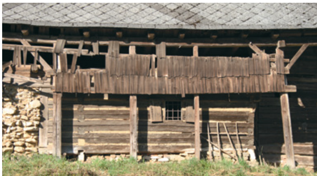
19. Severovýchodní trakt, severní část roubeného domu, 2015, foto V. Říhová. North-east wing, the northern part of the timbered house. Nordöstlicher Trakt, nördlicher Teil des Blockhauses.
